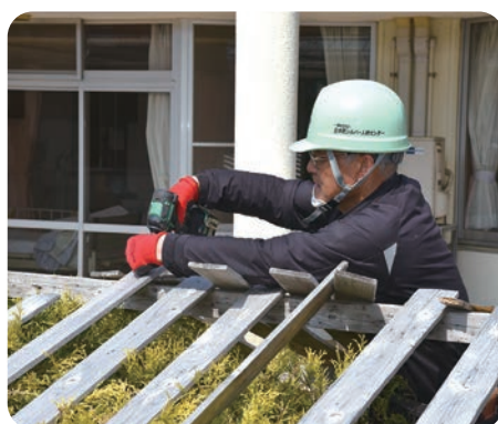
雪囲い撤去作業
