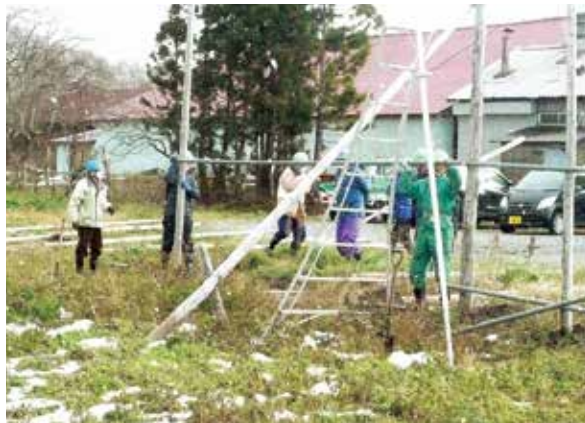
雪囲い作業現場
